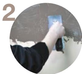
2 Еще через 4–6 часов нанесите металлической кельмой декоративное покрытие Lamarck. Рисунок формируется разнонаправленными волновыми движениями. Работать необходимо 1/3 поверхности инструмента.
