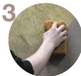
3 После растрескивания поверхности и полного высыхания материала губкой или варежкой наносится декоративное покрытие Orion. Материал сразу же растушевывается круговыми движениями, работать необходимо быстро, постоянно обновляя край нанесенного материала.
