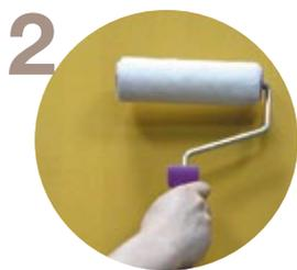
2 Через 2–4 часа нанесите кистью или валиком два слоя декоративного лака Mask. При нанесении избегайте подтеков! Дайте поверхности высохнуть.
