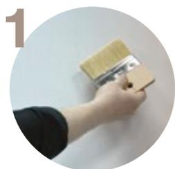
1 Нанесите с помощью валика два слоя подложки Latex Primer S. Дайте поверхности высохнуть. Через 2–4 часа нанесите кистью или валиком два слоя декоративного лака Mask. При нанесении избегайте подтеков! Дайте поверхности высохнуть.
